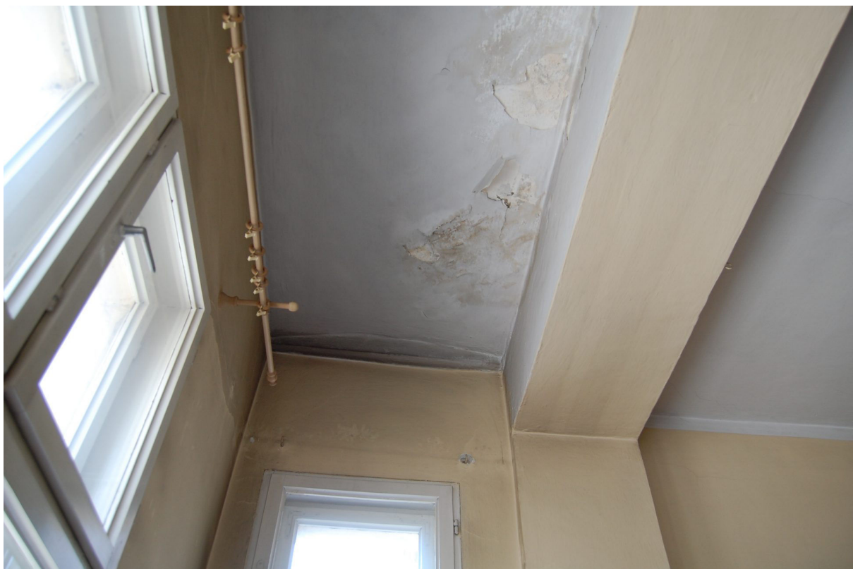
MIESZKANIE NR 4 – ZNISZCZONE FRAGMENTY SKLEPIENIA NAD WYKUSZEM
