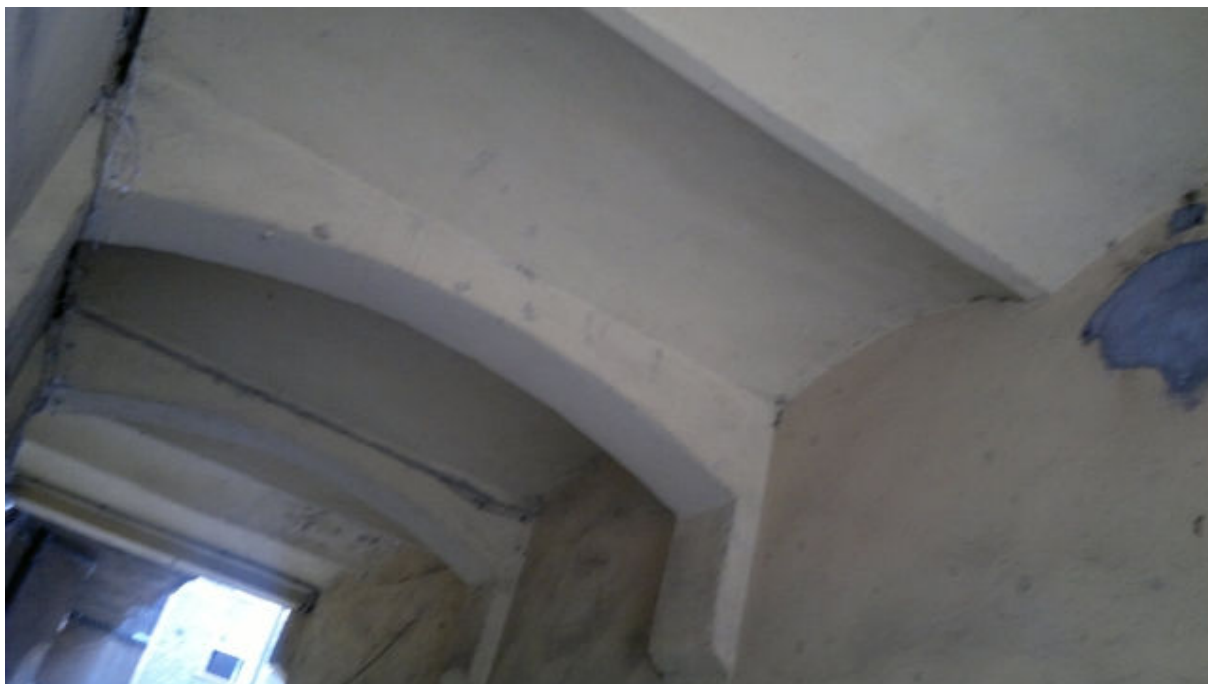
ELEMENTY NOŚNE STROPU NAD PRZEJAZDEM
