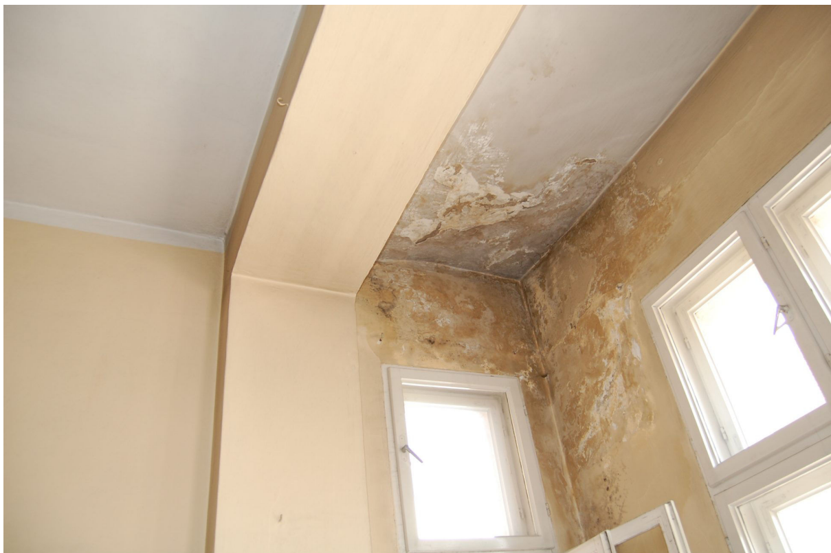
MIESZKANIE NR 4 – ZNISZCZONE FRAGMENTY SKLEPIENIA NAD WYKUSZEM
